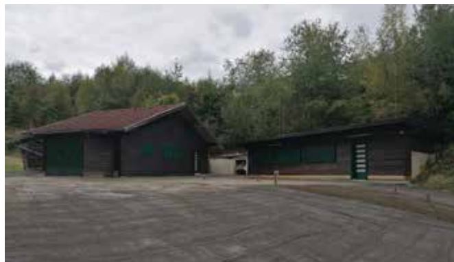
Die Außenanlagen am Waldschießstand sind fertig! (Foto: Klaus Pichler).
